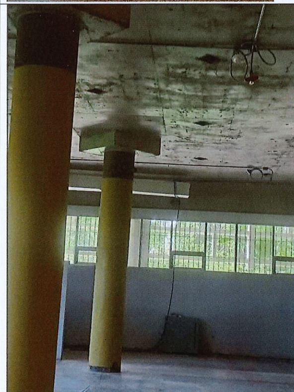
Biblioteca Reginal del Caribe: Remoción de asbesto, se quitaron las instalaciones de eléctricas de red por ethernet, y conductos de aire.
